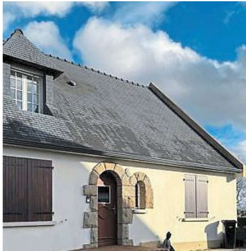
Vue du pavillon hébergeant la crèche dans le lotissement de La vallée, à Vezein-le-Coquet.
